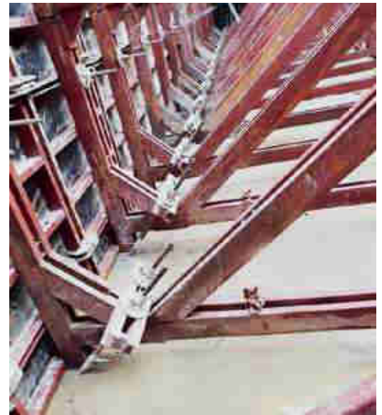
Esempio di parete predisposta al getto, con piastre a perdere annegate nella fondazione e tiranti recuperabili in primo piano.
