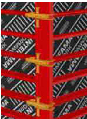
Vista angolo lato esterno
