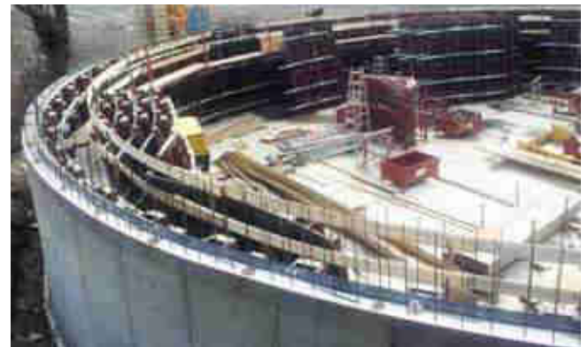
fase di ripresa - H. 6,0 m
